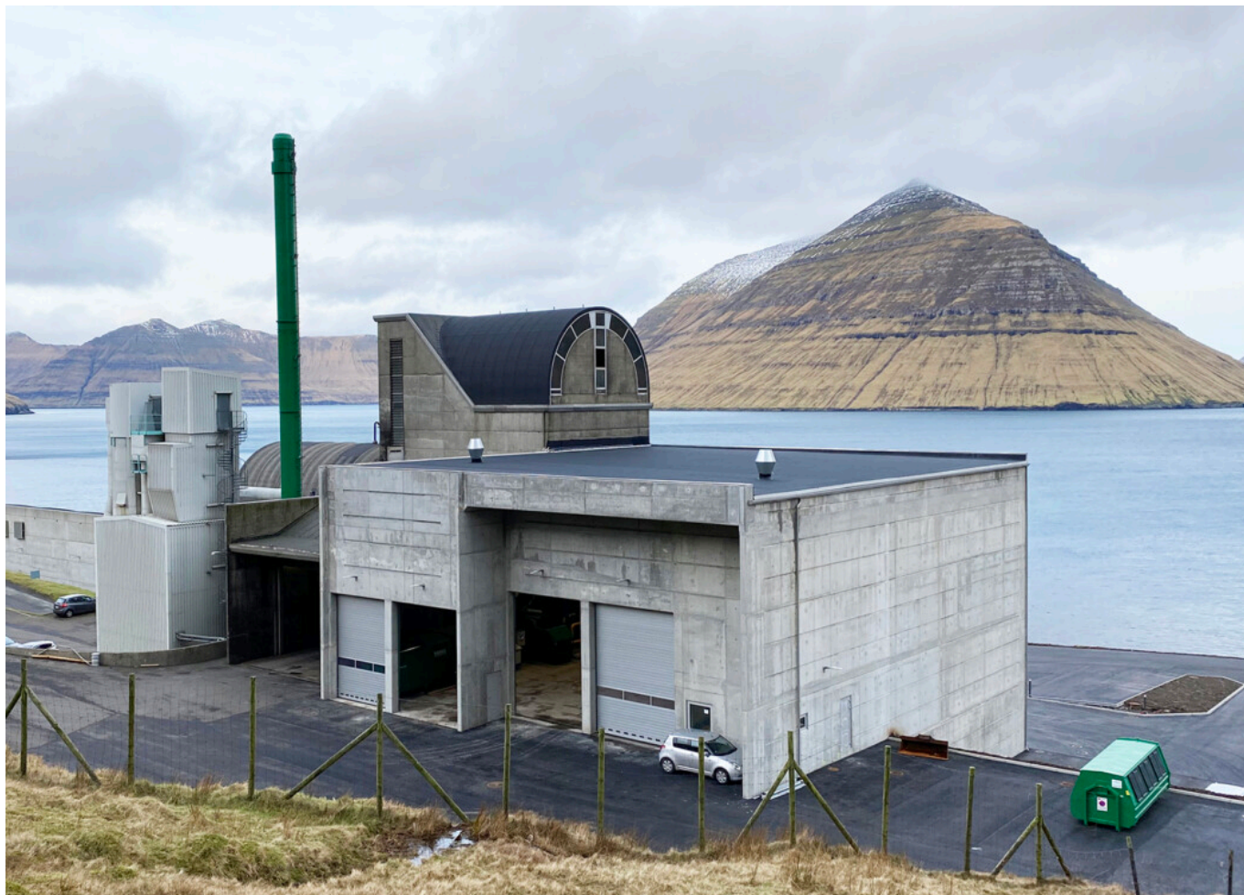
Nýggja høllin er bygd afturat Brennistöðini á Hagaleiti
