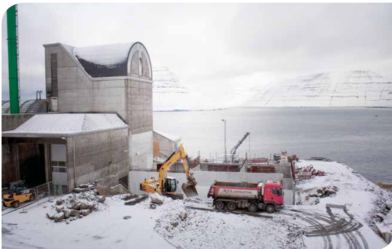
Arbeiðið at byggja móttøkuhøll á Hagaleiti er byrjað
